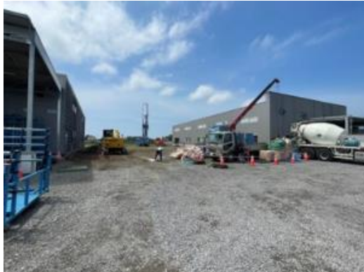
6/15より基礎工事スタート
